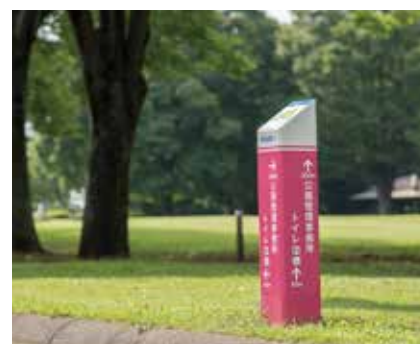
施工後：神奈川県立相模原公園誘導標・表示面作成、本体補修塗装（神奈川県相模原市）
