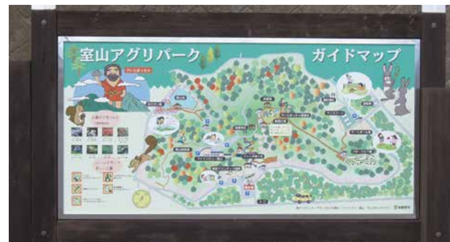
施工後：室山アグリパーク案内板・表示面作成、本体補修塗装（木製）（長野県安曇野市）
